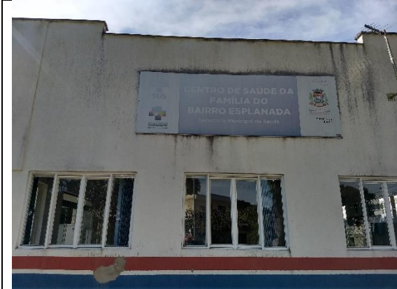
Placa a ser Substituída.
