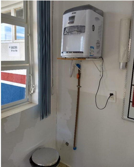
Tubulações a serem embutidas na parede.
