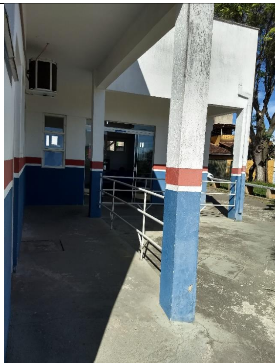
Área externa a receber pintura.
