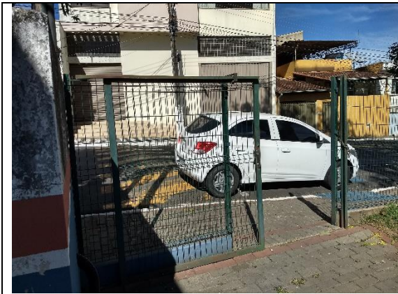
Portão que receberá pintura e lubrificação.
