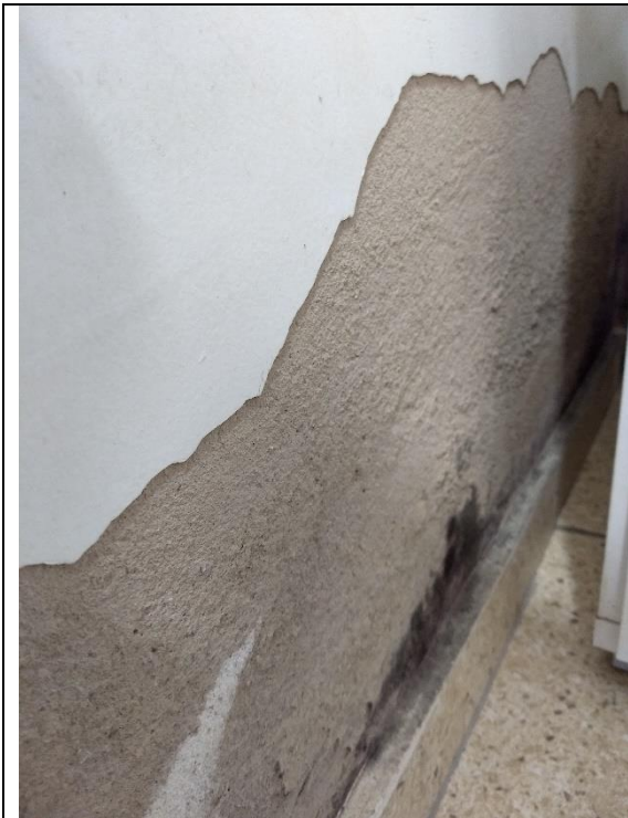
Paredes que serão tratadas até 1,0 m.
