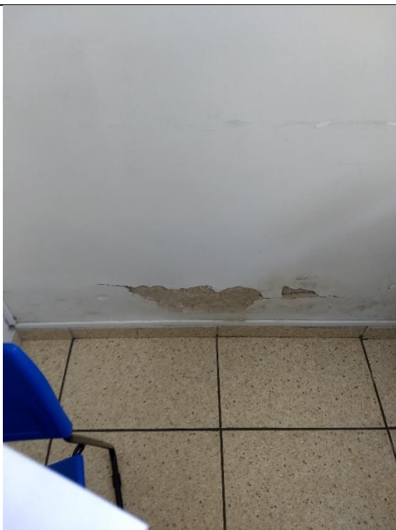
Paredes que serão tratadas até 0,5 m.
