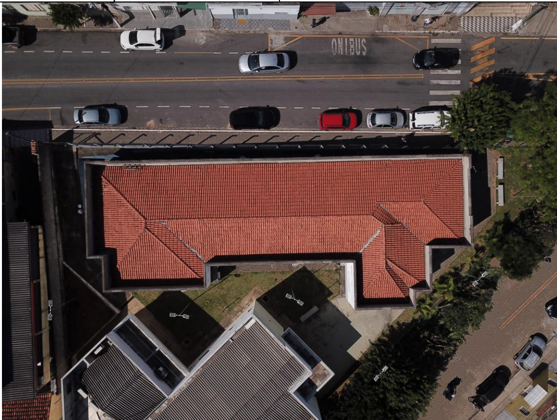
Telhado da UBS Esplanada (sobrevô).
