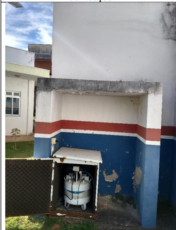
Área do compressor a ser preenchida com espuma anti chamas e fechada.
