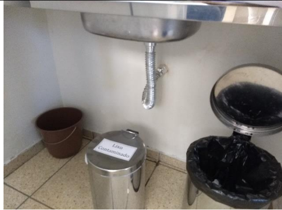
Parede da sala de vacina onde receberá revestimento cerâmico.
