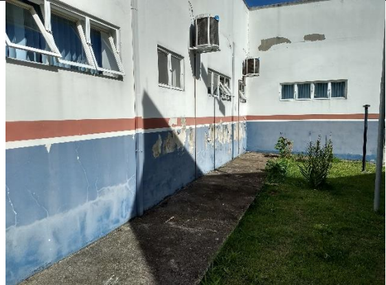
Paredes externas a serem tratadas e pintadas
