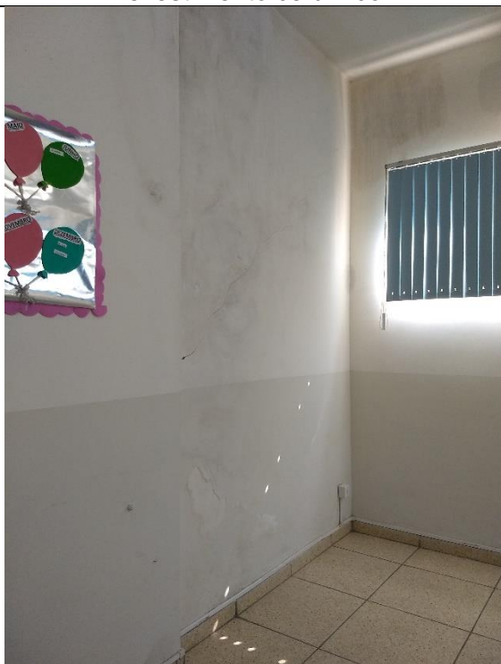
Paredes que serão tratadas por inteiro (pé direito total).
