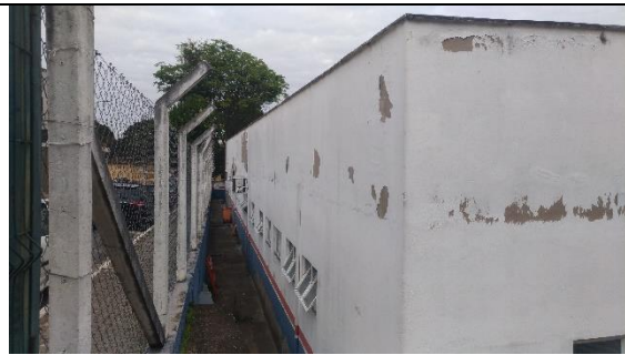
Postes alambrados que receberão pintura.
